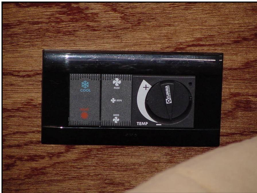
Figure 88 – Thermostat de réglage
