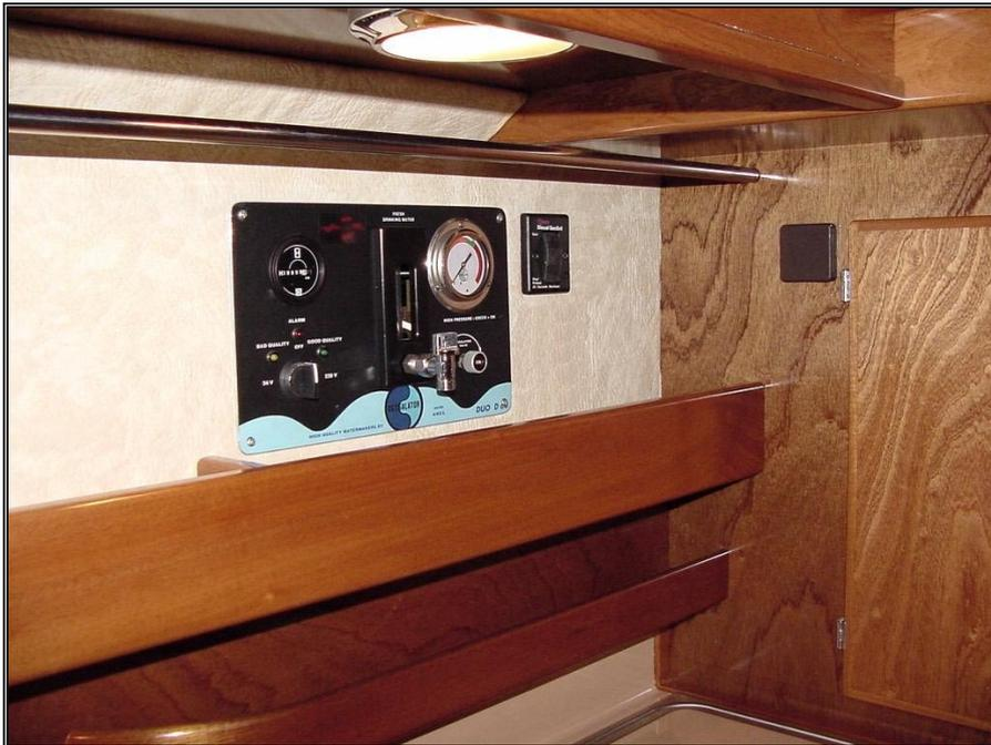
Figure 87 – Tableau de commande du dessalinisateur
