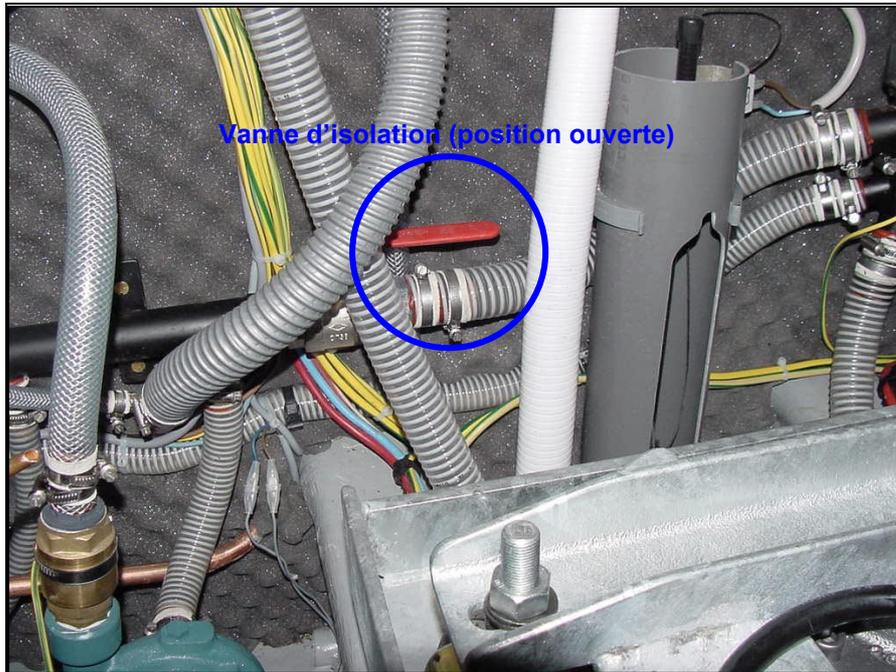
*Figure 67 – Vanne d'isolation (autres appareils que groupe électrogène et moteur)*
